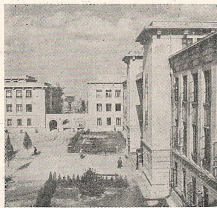
↑教室大樓側景，左邊相連的是主樓的一角
