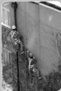
建筑物外墙粉刷
