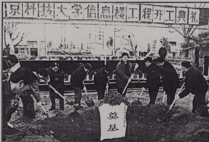
2003 年 12 月 31 日，毗邻新土木环境楼，我校又一座新楼——信息机电大楼开工
